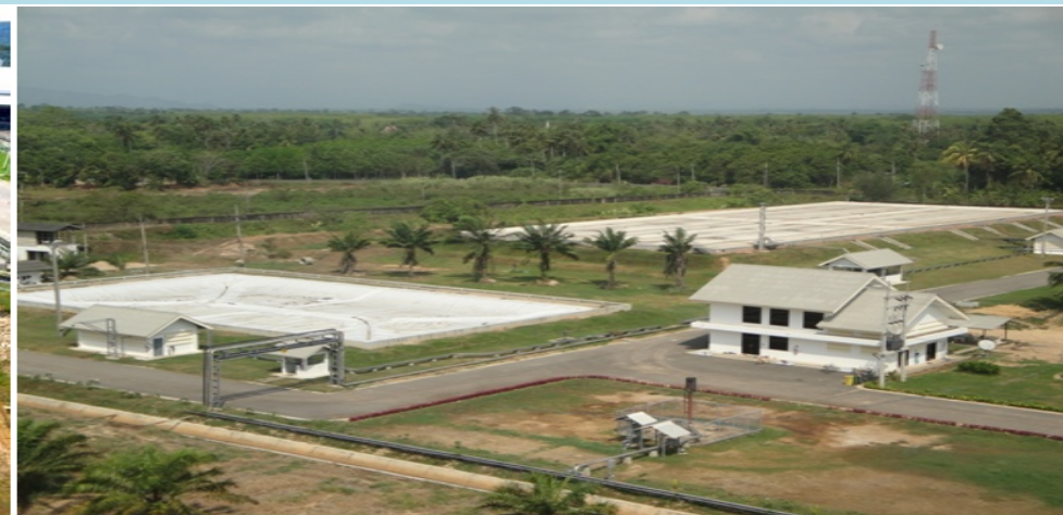
โรงงานผลิตสุราขาวและสุราผสม ผลิตก๊าซชีวภาพจากน้ำกากส่าใช้ ทดแทนน้ำมันเตา
