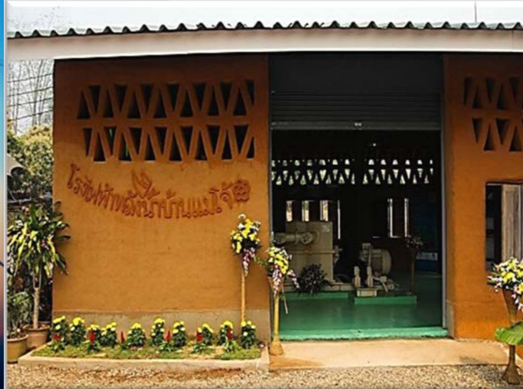
โรงไฟฟ้าพลังงานน้ำ
