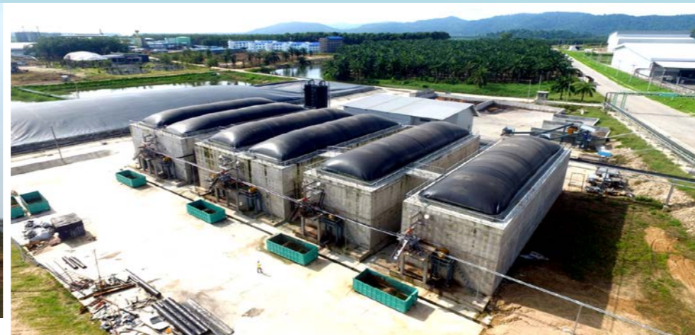
โรงงานแปรรูปปาล์มน้ำมันและยางพารา ผลิตก๊าซชีวภาพเพื่อใช้ในการอบยางแท่ง
