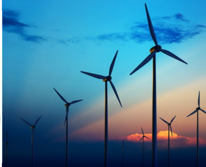
โรงไฟฟ้าพลังงานลม
